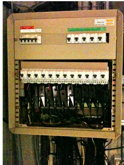
Figure 3 - Les pinces dans notre tableau électrique
